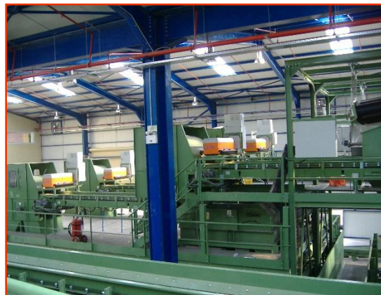
Αυτοματοποιημένο Κέντρο Διαλογής Ανακυκλώσιμων Υλικών Συσκευασίας (Ασπρόπυργος 2008)
